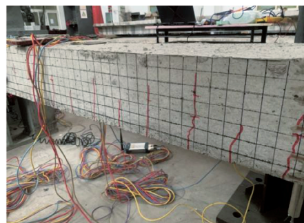
b) 纯弯段裂缝
