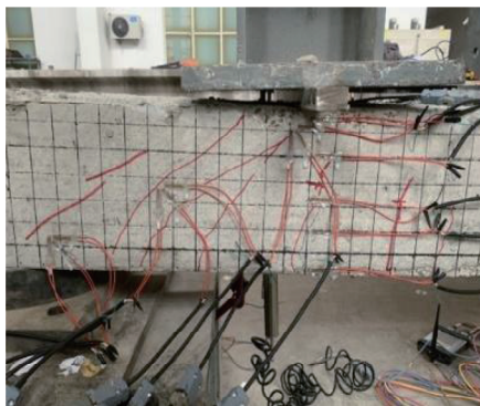
a) 剪压区裂缝
